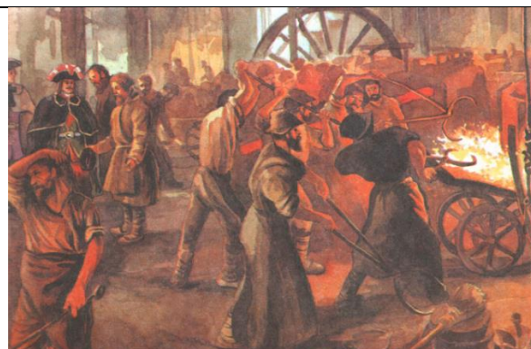
Завод петровских времен
